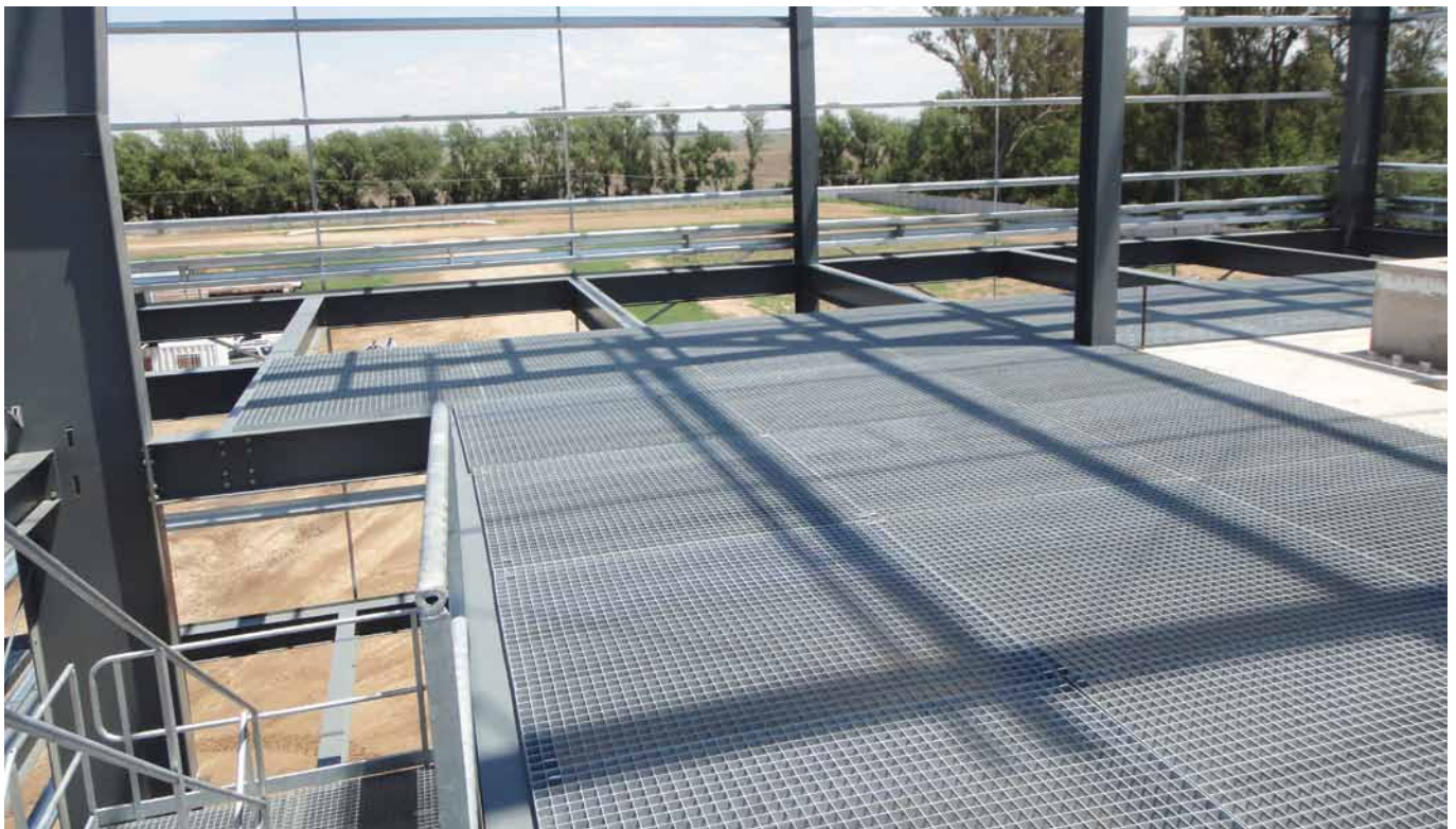
Vista del galpón donde se montarán la turbina, la caja reductora y el generador. Foto: gentileza CAPP.
