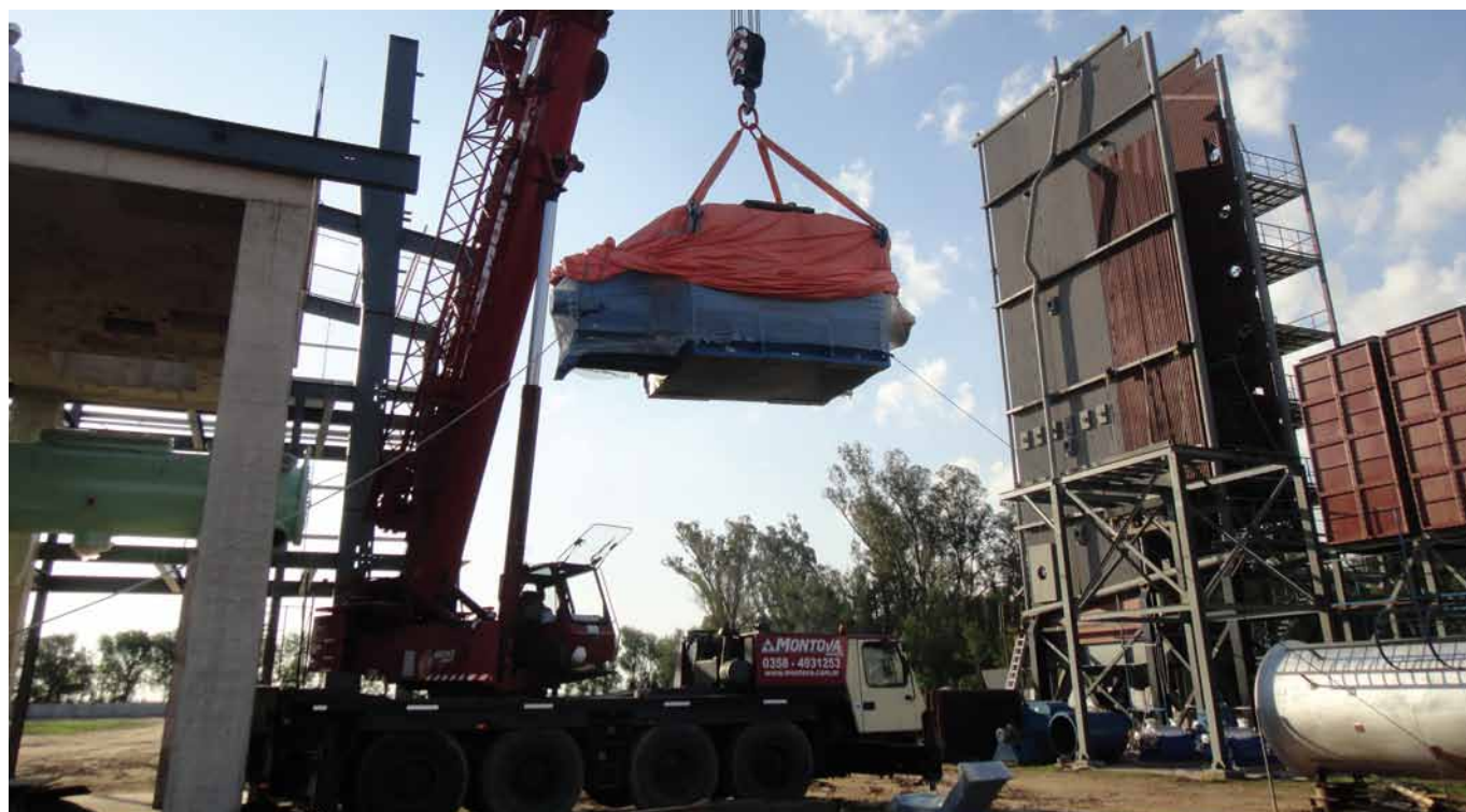
Maniobra de izado del generador. Colocación del generador en su lugar definitivo dentro del esqueleto del galpón. Foto: gentileza CAPP.
