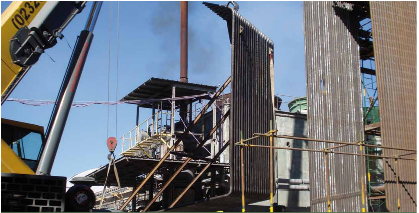
Montaje del cuerpo de presión de la caldera. Foto: gentileza CAPP.
